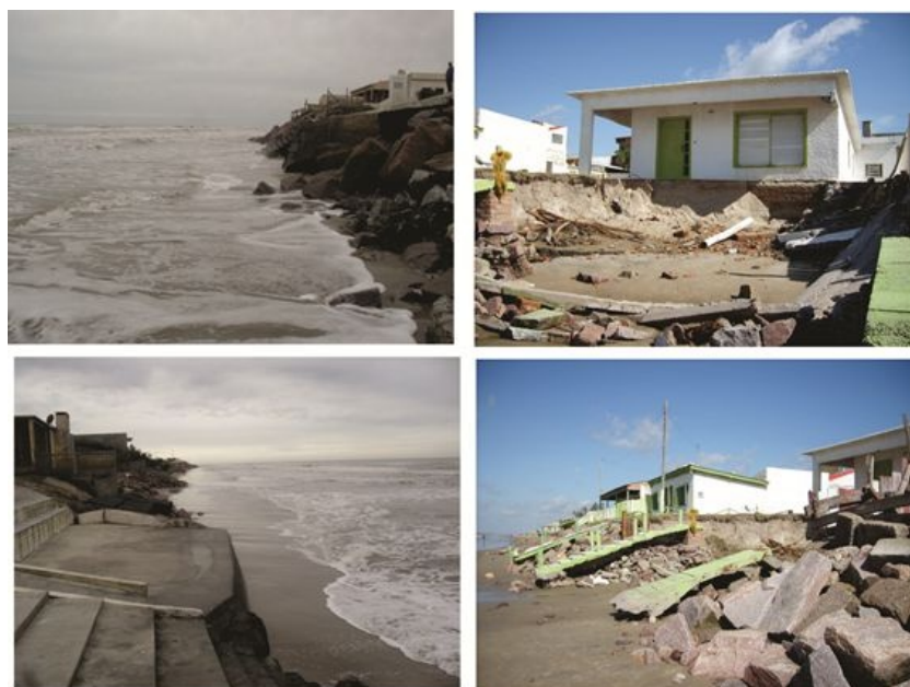
Figura 4. Exemplos de obras de proteção realizadas por particulares e que agravaram a erosão em áreas desprotegidas. Fotos de Miguel da Guia Albuquerque.
